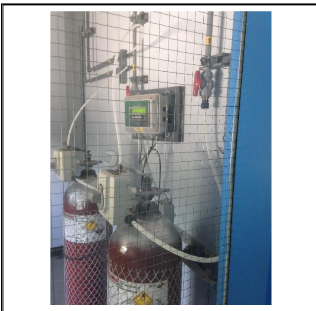
Photo 7 Date 8 juin 2017 Description : Réservoirs surpressés de chlore gazeux.
